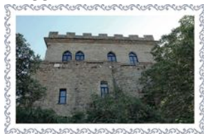
Castello di Muggia, Muggia - TS
