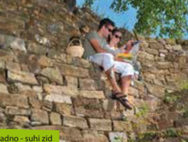
Gradno - suhi zid
